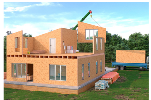
Fig. 54. Construirea unei case modulare din materiale lemnoase
