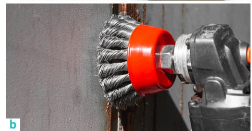
Fig. 16. Curățarea ruginii manual și mecanic
