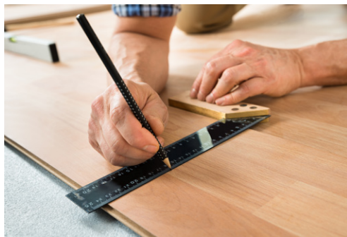
Fig. 20. Măsurarea și trasarea
