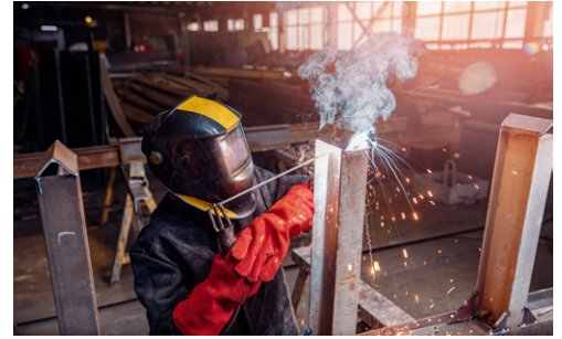
Fig. 23. Folosirea echipamentului de protecție în timpul operației de sudare
