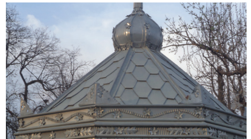
Fig. 32. Învelitoare pentru acoperiș din tablă zincată cu ornamente dantelate
